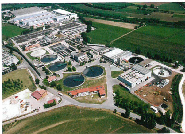
The purification system in Arzignano Il depuratore di Arzignano
